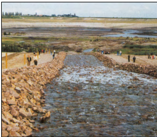
Abb. 2.6 Flutungsanlage von der Mulde bis zum Restloch Mühlbeck (LMBV 1999A, LMBV 1999B).
